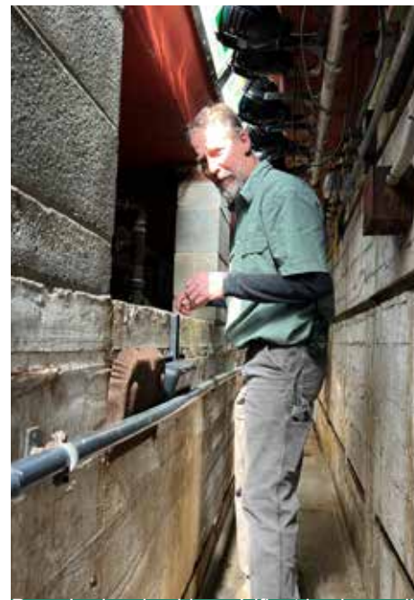
Dana Lysle, plombier, vérifiant le niveau d'eau du réservoir souterrain contenant 9 500 litres d'eau recirculant en circuit fermé lorsque les fontaines jouent.
